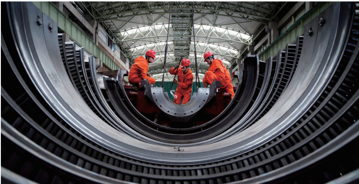
寿光1号机组汽轮机安装
