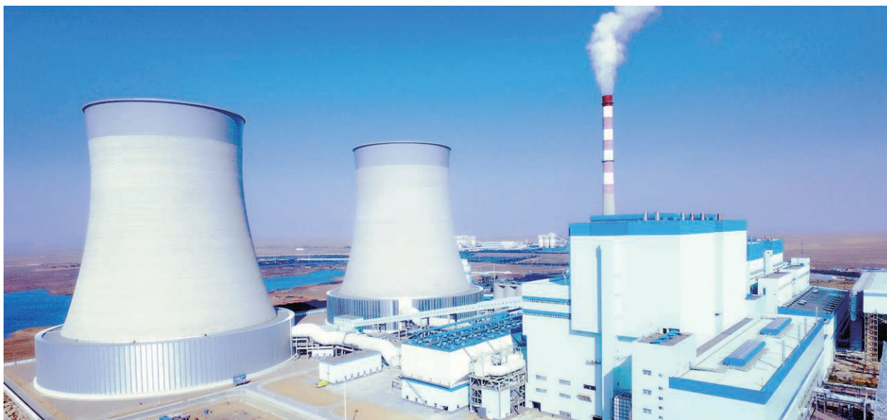
国华电力宁东电厂
